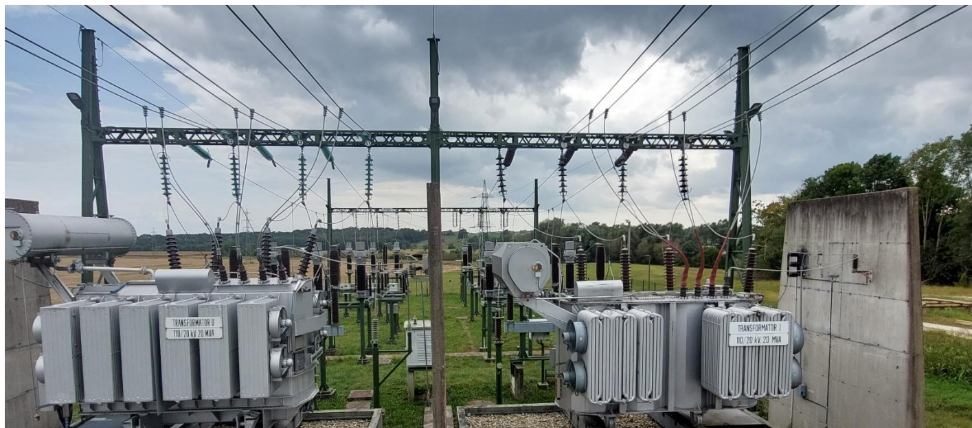
Demontaža prostozačnih povezav med 110/20 kV TR in 20 kV TR celicami
